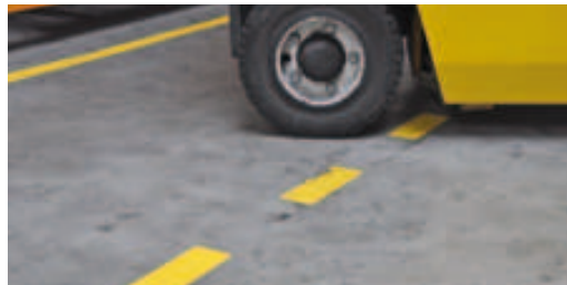
Beschädigung nur an einzelnen Segmenten
